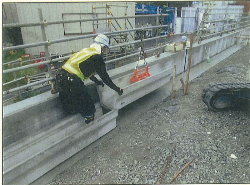
排水設備・転落防止柵設置 (転落防止柵設置、排水設備)
