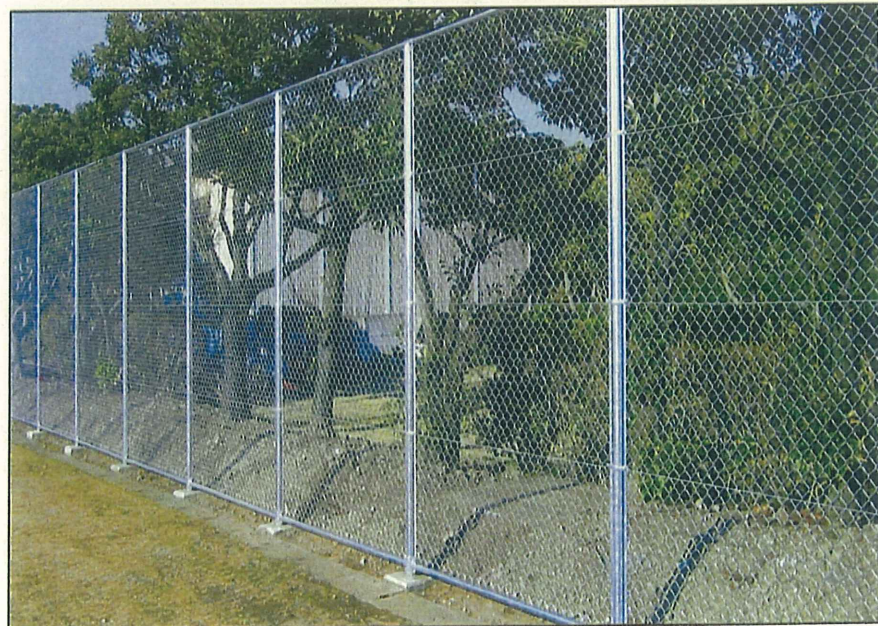
ネットフェンス設置 (高さ 2m)
