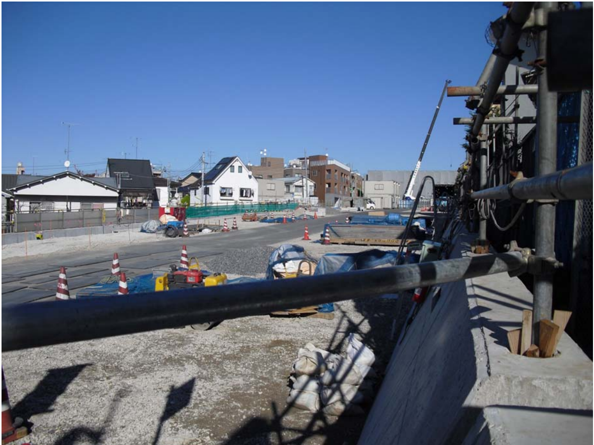
写真 13 東北沢 3 号踏切～東北沢 2 号踏切 南側の擁壁（高さ 70 c m程度）
