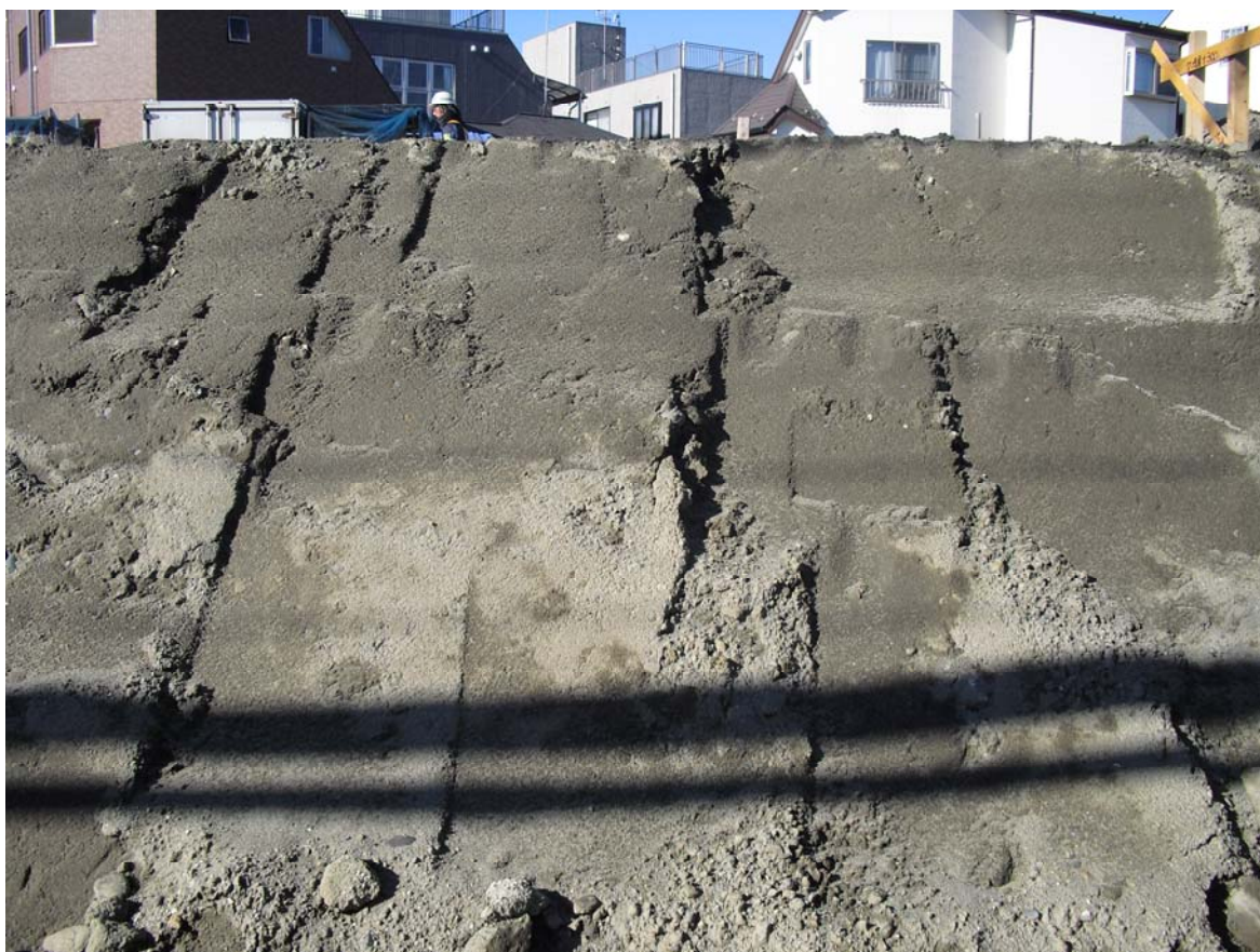
写真2 東北沢4号踏切付近 南側の盛り土
