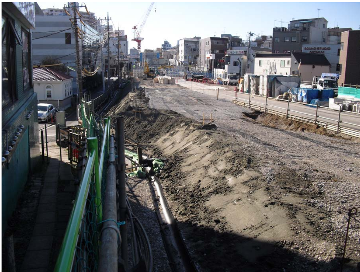
写真1 東北沢4号踏切～東北沢3号踏切 南側の盛り土
