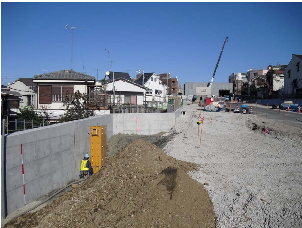
写真 12 同上 擁壁内側に土を入れて造成している様子
