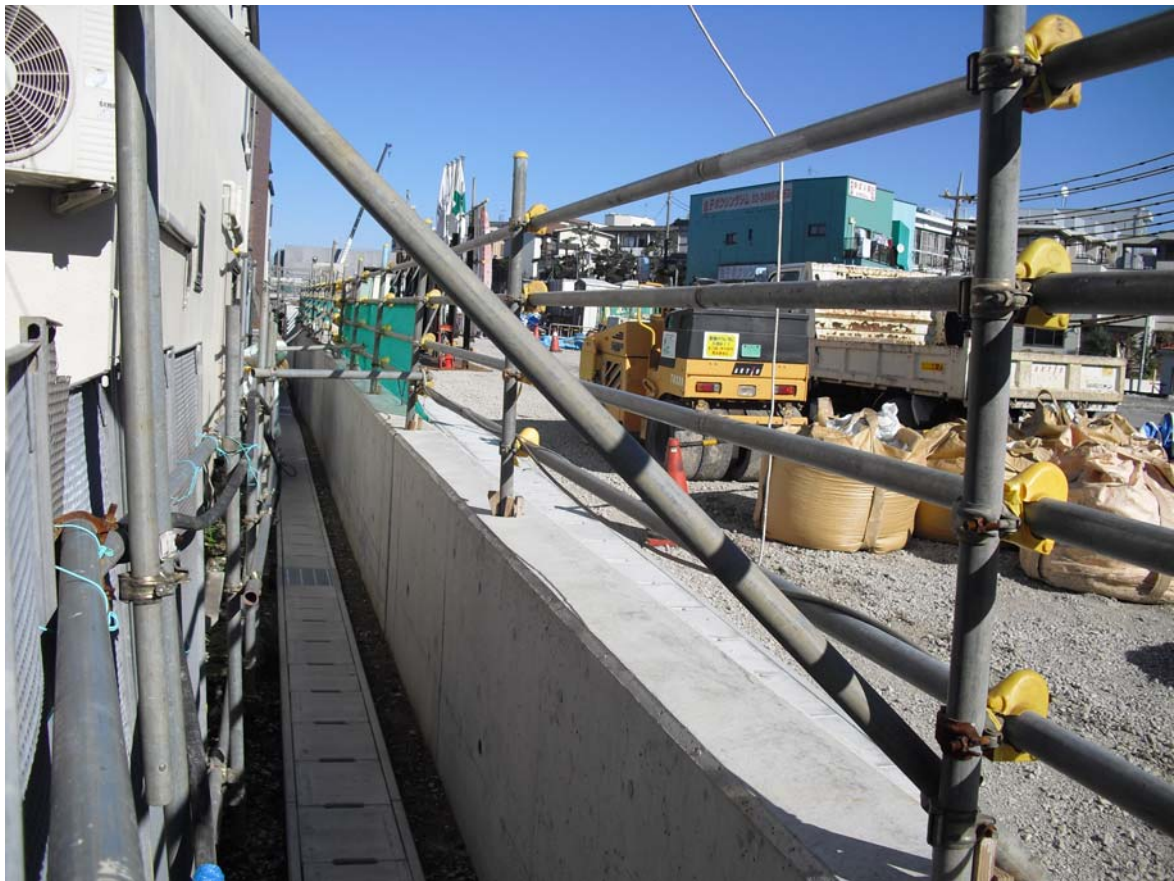
写真3 東北沢4号踏切付近 北側の擁壁（高さ1.5m程度）
