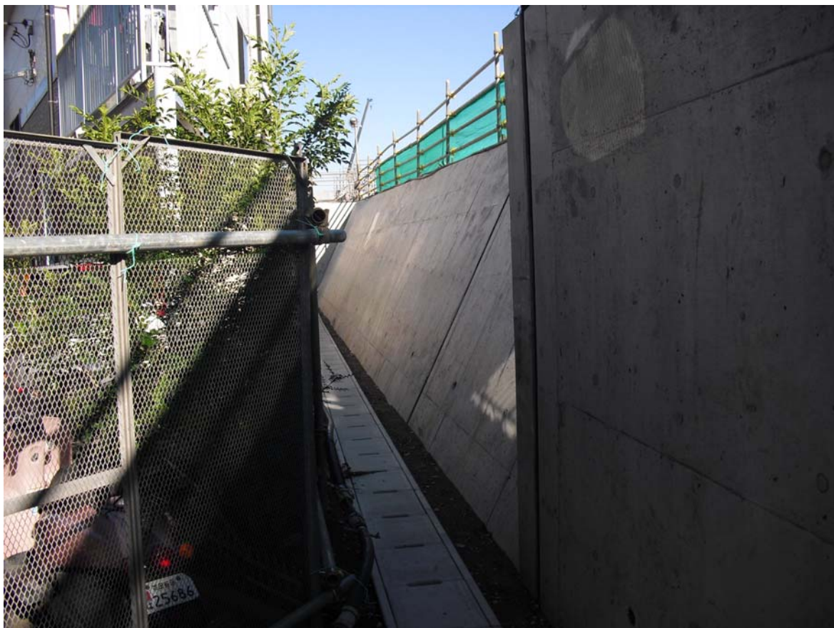
写真9 東北沢4号踏切～東北沢3号踏切 北側の擁壁（高さ2m～2.5m程度）
