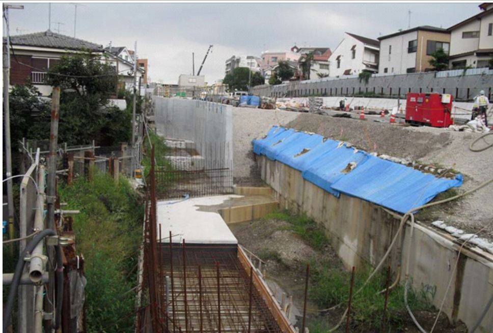
小田急地下連立事業で出現した高さ4mの擁壁。造成地に賃貸住宅や商業施設が予定されている
