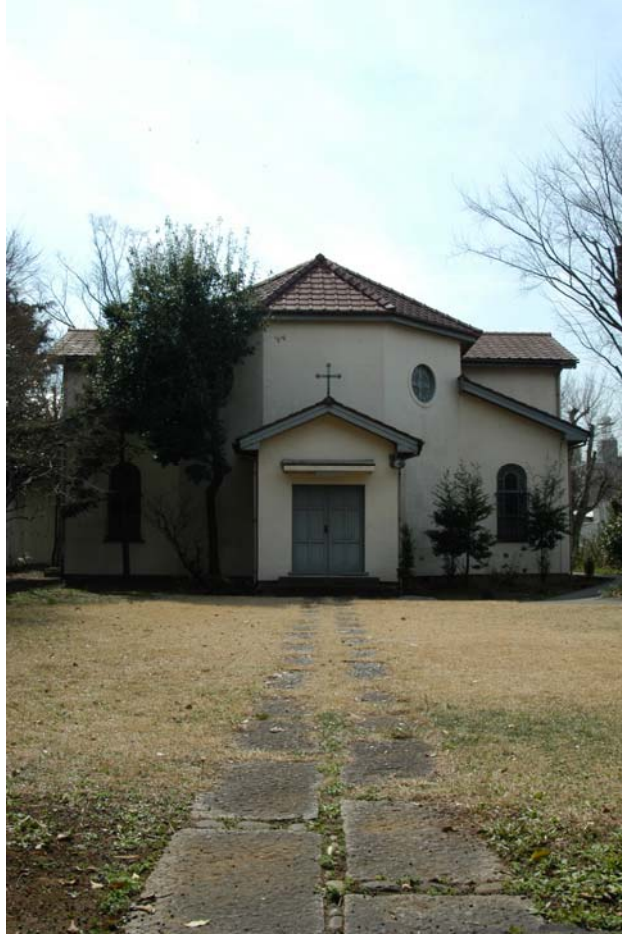
3. 住宅街のなかに静かに佇む世田谷教会。 補助54号線の計画予定地。
